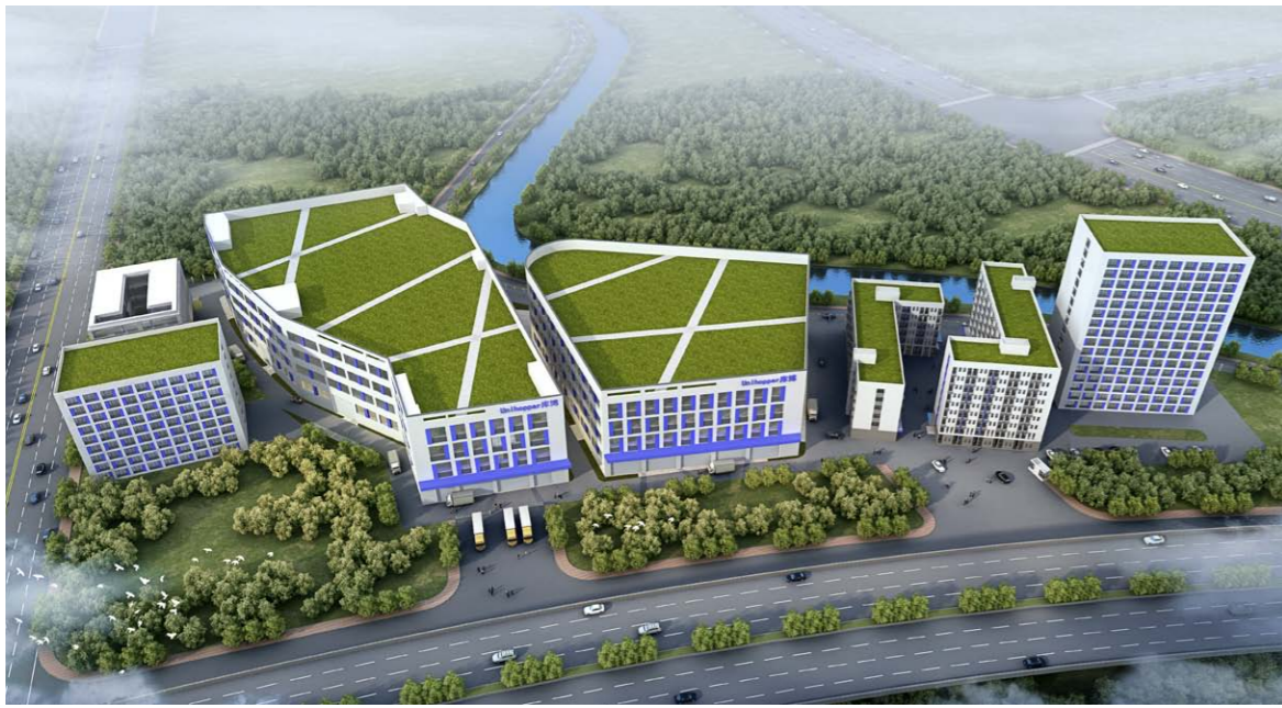
Unihopper Intelligent industrial park 库博智能化工业园
