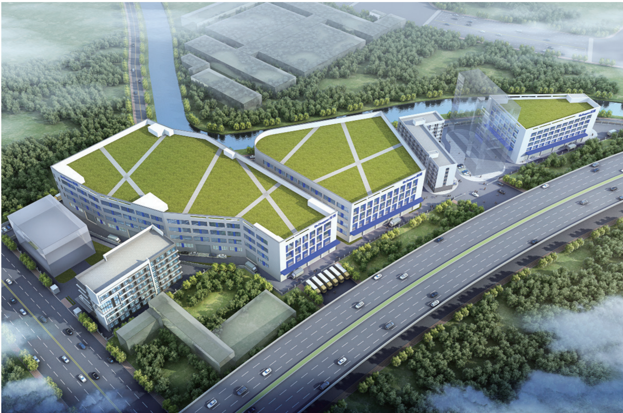
Unihopper Intelligent industrial park 库博智能化工业园
