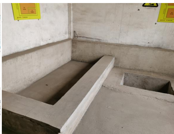
危废贮存库贮存分区局部
