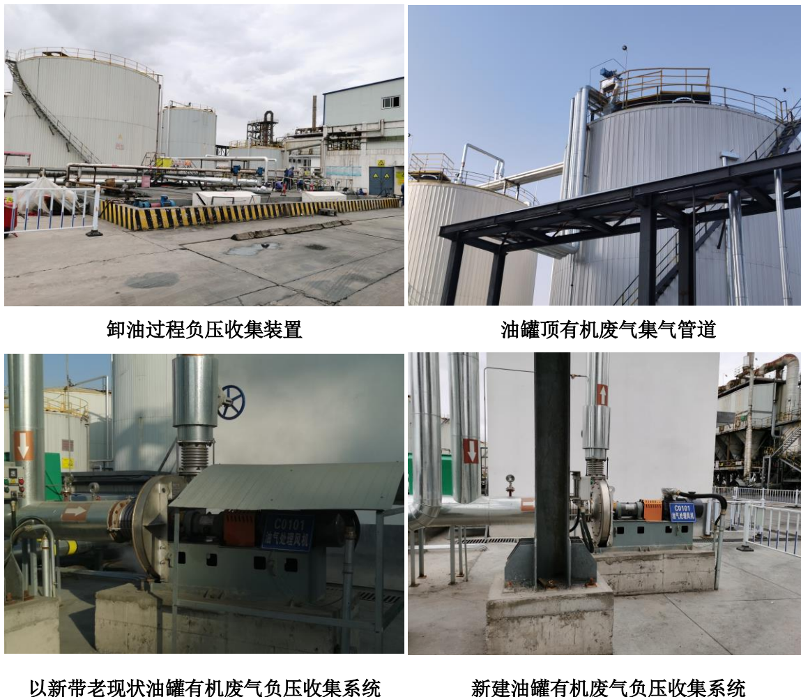
图 4.1-6 油罐区及卸油无组织废气治理设施图
