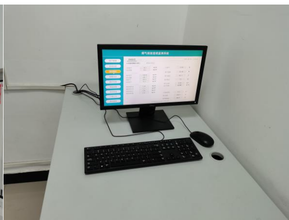
废气在线监测监控系统
