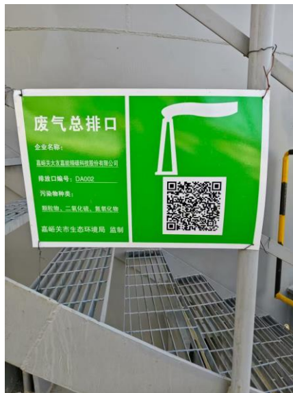
总废气排口标志牌
