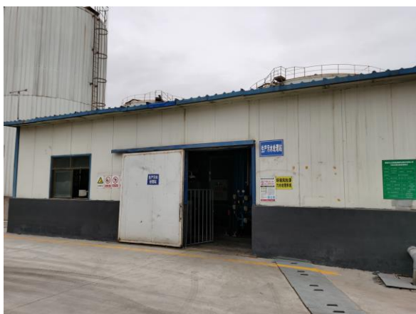
生产污水处理站
