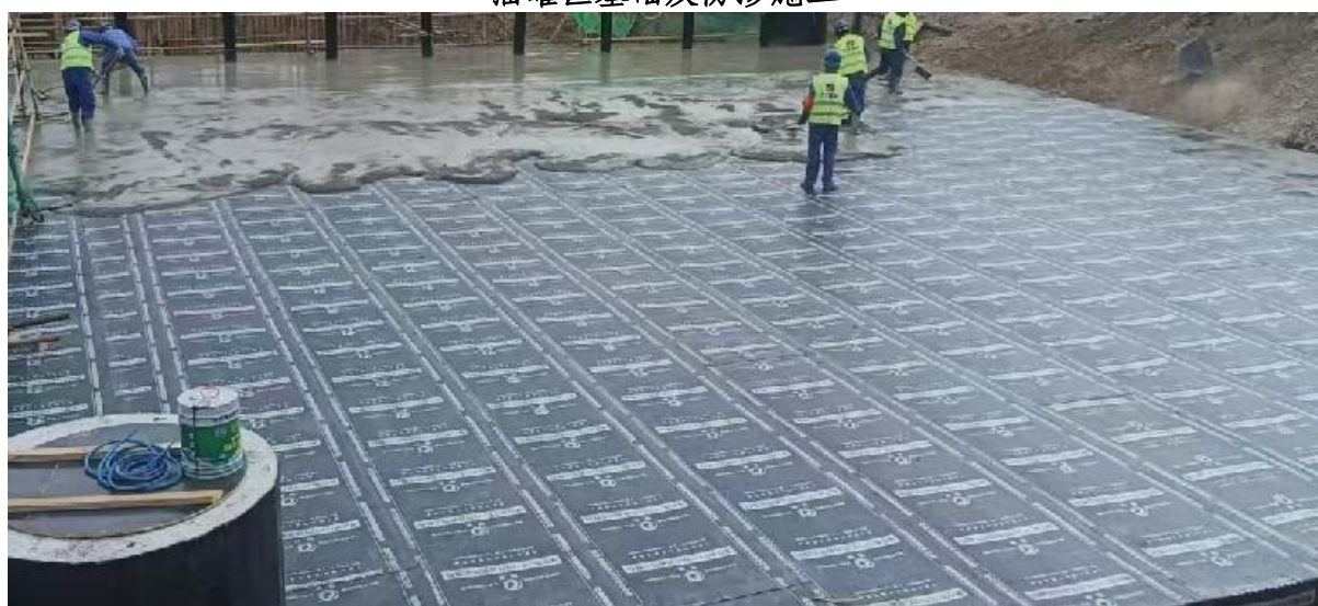
事故池防渗施工现场
