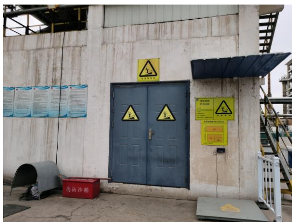
现有危废贮存库
