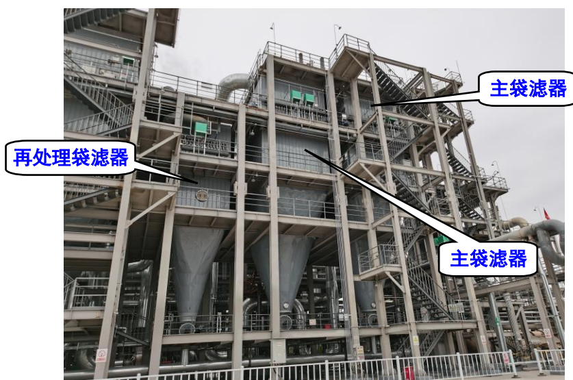
图 4.1-4 项目新建炭黑生产线废气处理设施图
