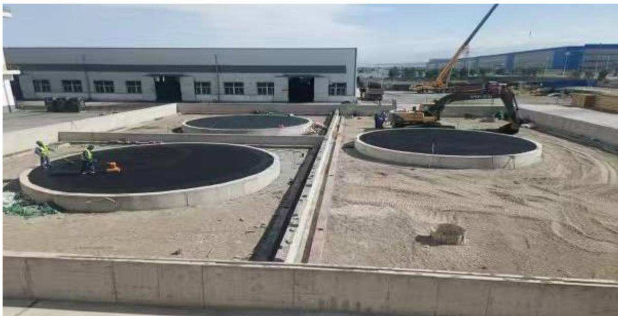
油罐区基础及防渗施工
