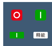
断路器合闸且无储能状态
