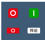
断路器断开且无储能状态
